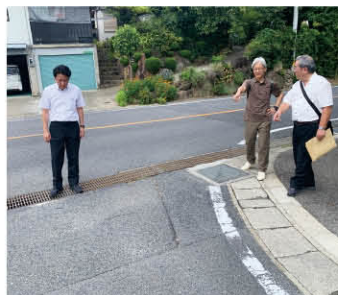
▲ 御立町県道段差整備
