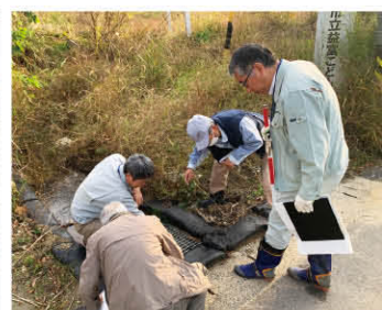
▲ 志賀町土砂対策
