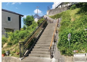
▲野見山町手すり設置
