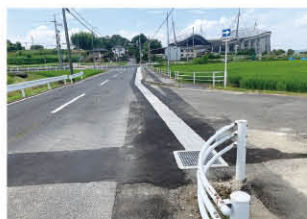
▲森町側溝新設
