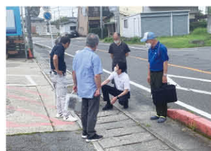
▲広川町県道側溝改築
