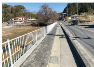
▲志賀町荒田の交差点歩道拡幅
