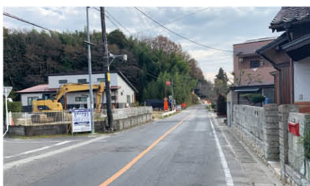
▲ 県道細川豊田線歩道整備
