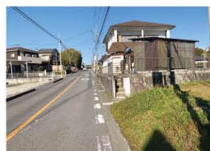
▲上野大見線歩道新設整備
