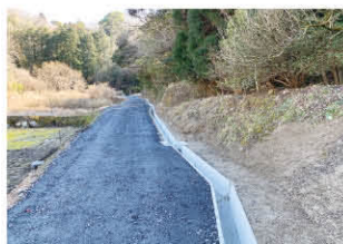
▲大見町側溝新設
